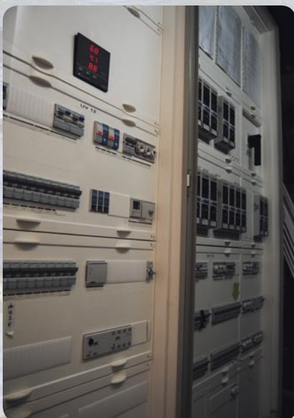
Bild 7: Sensoren überwachen die Energieanlage des Schiffes.
